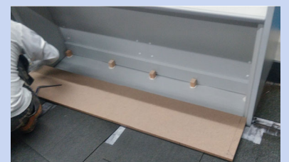
床段差解消のため塞ぎ板設置
