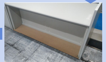
塞ぎ板設置完了
