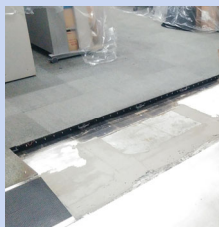
既存品を撤去
